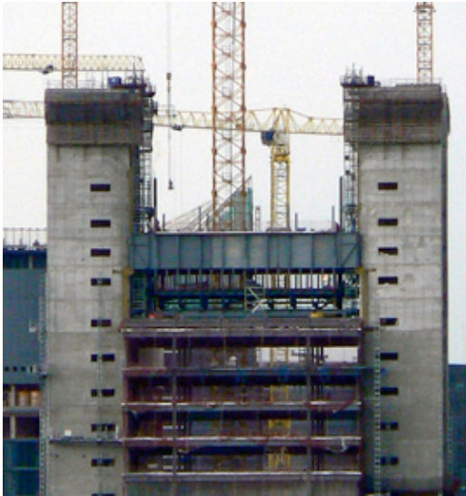
La Torre antes del izado de la cubierta
