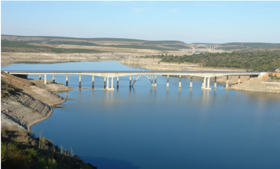
Vista del puente El Manzanal
